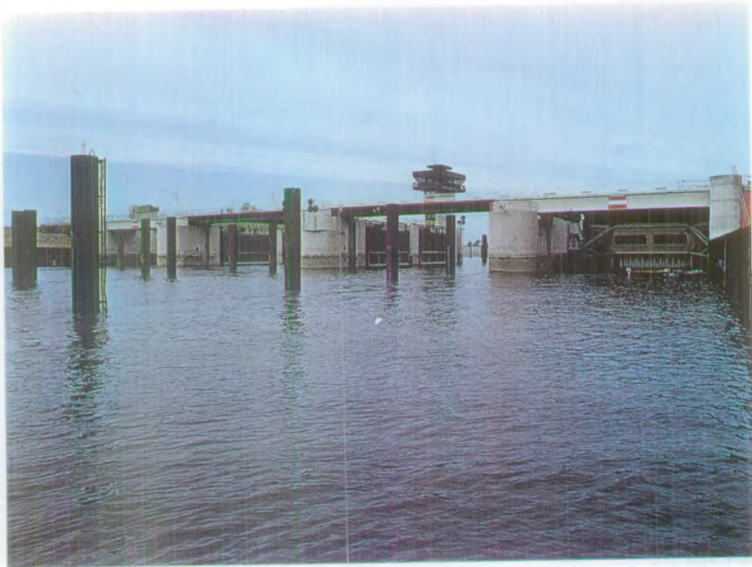
Ansicht von oberstrom
